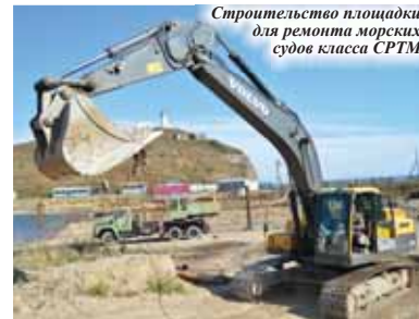
Строительство площадки для ремонта морских судов класса СРТМ
