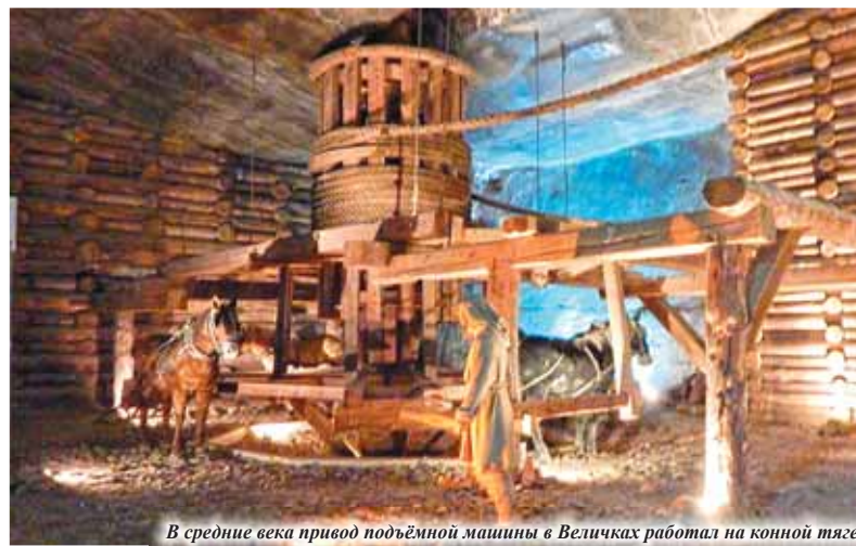
В средние века привод подъёмной машины в Величках работал на конной тяге
